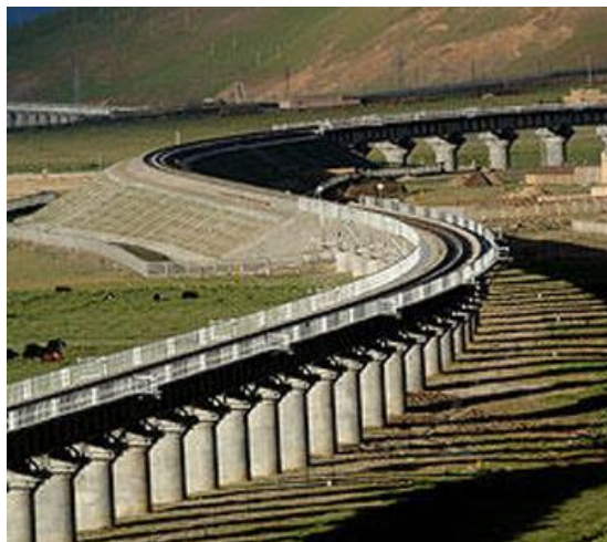
รูปที่ 6 สะพานทางรถไฟชิงไห่-ทิเบต ในประเทศจีน [19]
