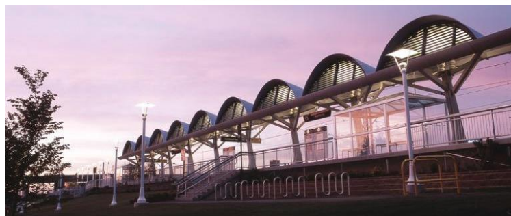
รูปที่ 4 สถานีรถไฟรางเบาซอร์เนสซี ประเทศแคนาดา และองค์อาคารที่หล่อด้วย RPC [13, 19]
