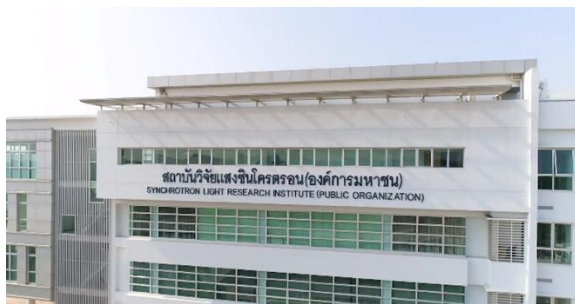
(ก) อาคารสถาบันวิจัยแสงซินโครตรอน จ.นครราชสีมา
