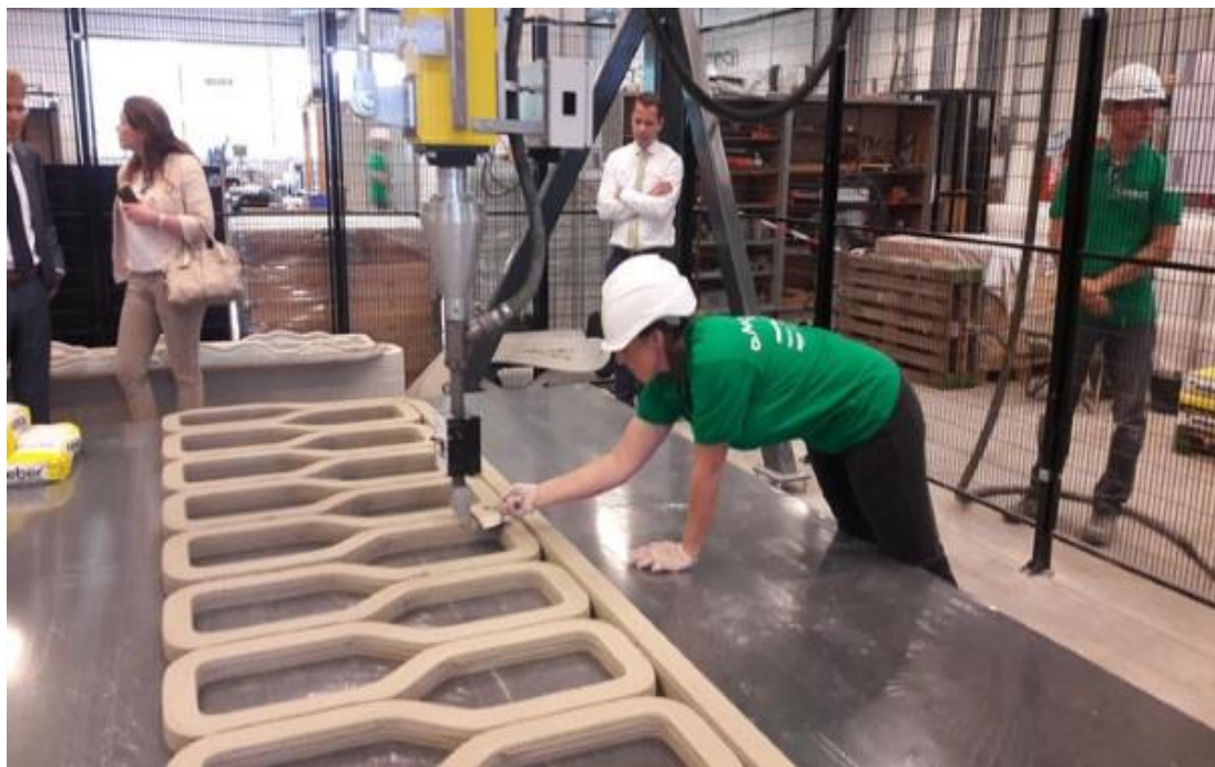
สะพานคอนกรีตด้วย 3D Printing (ที่มา https://goo.gl/Wppsgv )
