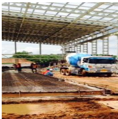
ภาพที่ 1 การทำงานพื้นคอนกรีตวางบนดิน
