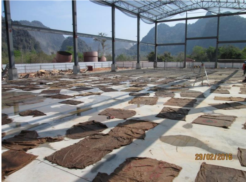
ภาพที่ 6 การบ่มผิวคอนกรีตที่เหมาะสม
