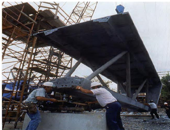
รูปที่ 2 การประกอบสะพานใน Sherbrooke
