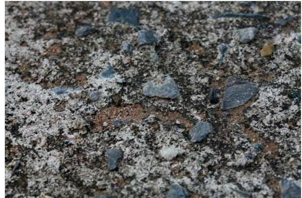
รูปที่ 1 ลักษณะการสึกกร่อนของผิวถนนคอนกรีตเสริมเหล็ก
