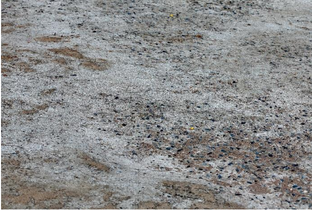
รูปที่ 1 ลักษณะการสึกกร่อนของผิวถนนคอนกรีตเสริมเหล็ก
