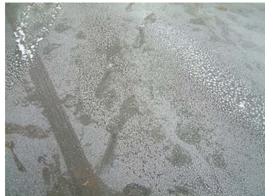
รูปที่ 11 พื้นที่ขัดแต่งผิวหน้าเสร็จต้องทำการบ่มทันที ในภาพบ่มด้วย Curing Compound เกิดอะไรขึ้นถ้าเริ่มขัดแต่งผิวหน้าช้าเกินไป
