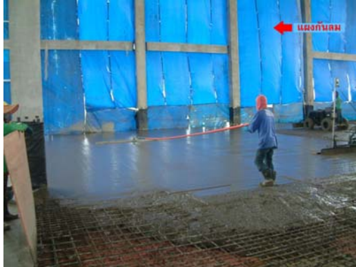
รูปที่ 7 การใช้ Bull Float ในการปรับความเรียบของพื้น
