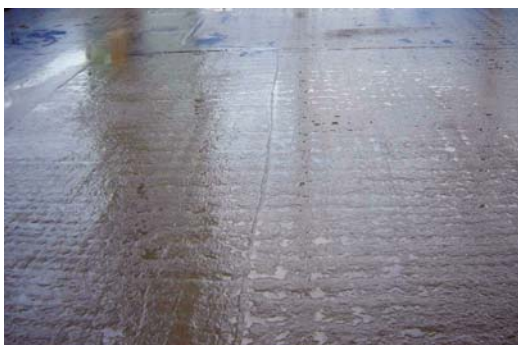
รูปที่ 2 ปริมาณเยิ้มน้ำ (Bleeding) ที่เหมาะสม ไม่มากและไม่น้อยเกินไป
