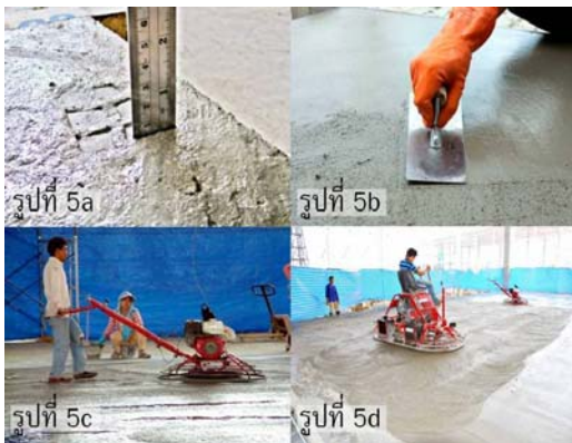
รูปที่ 5a รอย Footprint และการวัดความลึกบนพื้นคอนกรีตในขณะที่กำลังก่อตัว รูปที่ 5b การขัดด้วยมือ รูปที่ 5c การขัดด้วยเครื่องขัดแบบเดินตาม รูปที่ 5d การขัดด้วยเครื่องขัดแบบคนนั่ง
