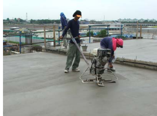
รูปที่ 8 ขั้นตอนการขัดแบบ Troweling ด้วยใบพัด
