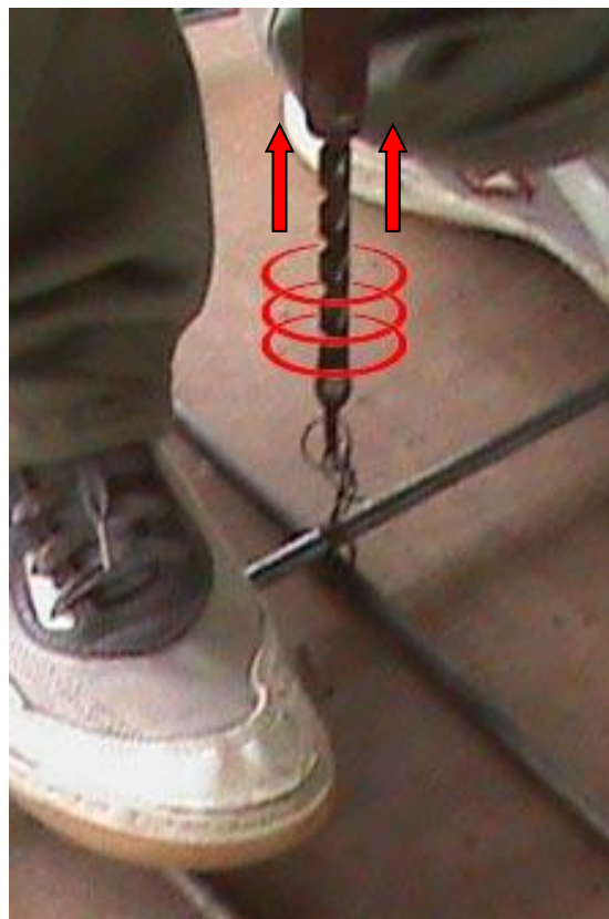
รูปที่ 7 การทำงานของเครื่องมือผูกเหล็ก
