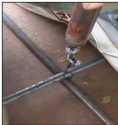
รูปที่ 5 ทำการเกี่ยวลวดที่ผูกแล้วใช้เครื่องช่วยผูกเหล็กดึง
