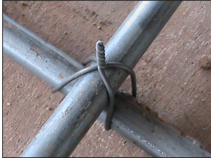
รูปที่ 6 การผูกเหล็กที่ได้จากเครื่องมือผูกเหล็ก
