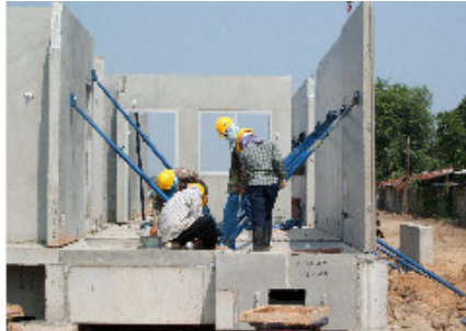
ข. การใช้ค้ำยันชั่วคราวเพื่อยึดให้ผนังคอนกรีตอยู่กับที่
