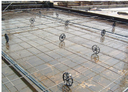
รูปที่ 1 การเตรียมแบบหล่อและจัดวางเหล็กเสริม
