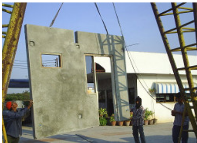
รูปที่ 3 การยกขนย้ายชิ้นส่วนผนังคอนกรีตหลังการถอดแบบ
