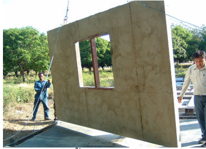
ก. การยกติดตั้งผนังคอนกรีตหล่อสำเร็จ
