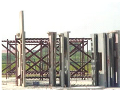
รูปที่ 4 การจัดวางชิ้นส่วนผนังคอนกรีตสำเร็จรูปเพื่อเตรียมขนส่งไปยังสถานที่ก่อสร้าง
