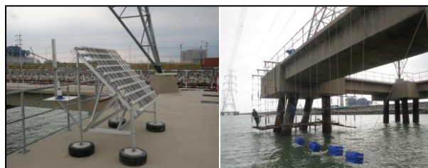
รูปที่ 2 การติดตั้งขึ้นตัวอย่าง
