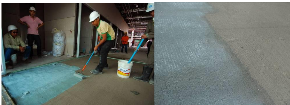
การทาน้ำยาเชื่อมประสานคอนกรีต
