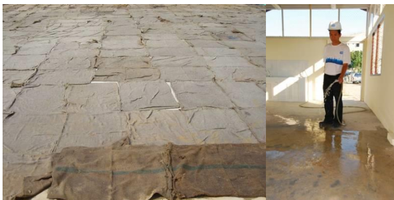
การบ่มคอนกรีตหลังจากคอนกรีตแข็งตัวแล้ว
