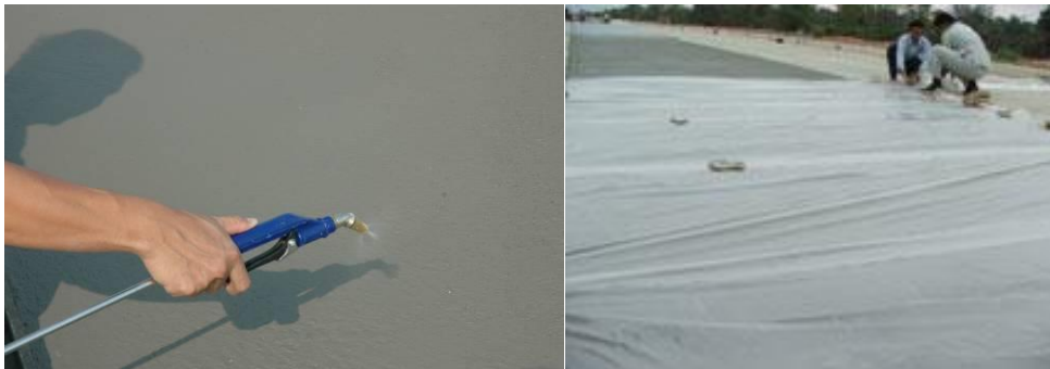
การบ่มคอนกรีตหลังจากเทเสร็จ
