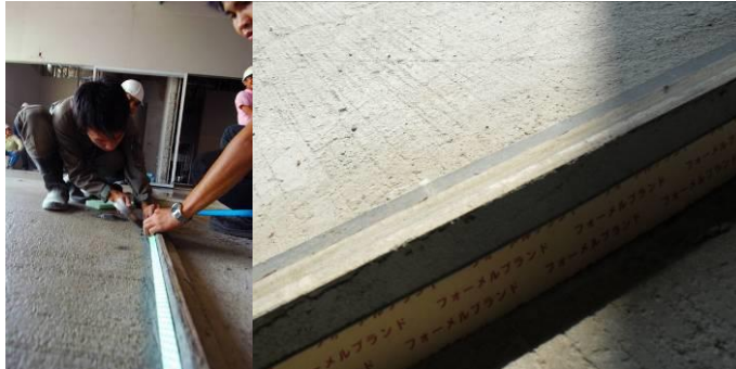
การทำรอยต่อระหว่างพื้นกับขอบแบบ
