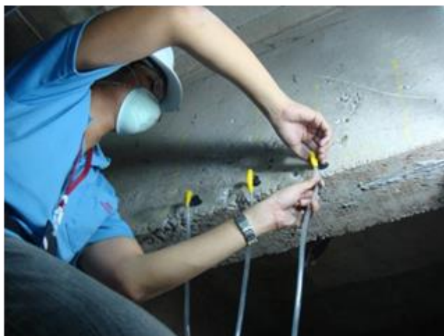
รูปที่ 4 การติดตั้งเพื่อทดสอบความสามารถในการซึมซาบอากาศ
