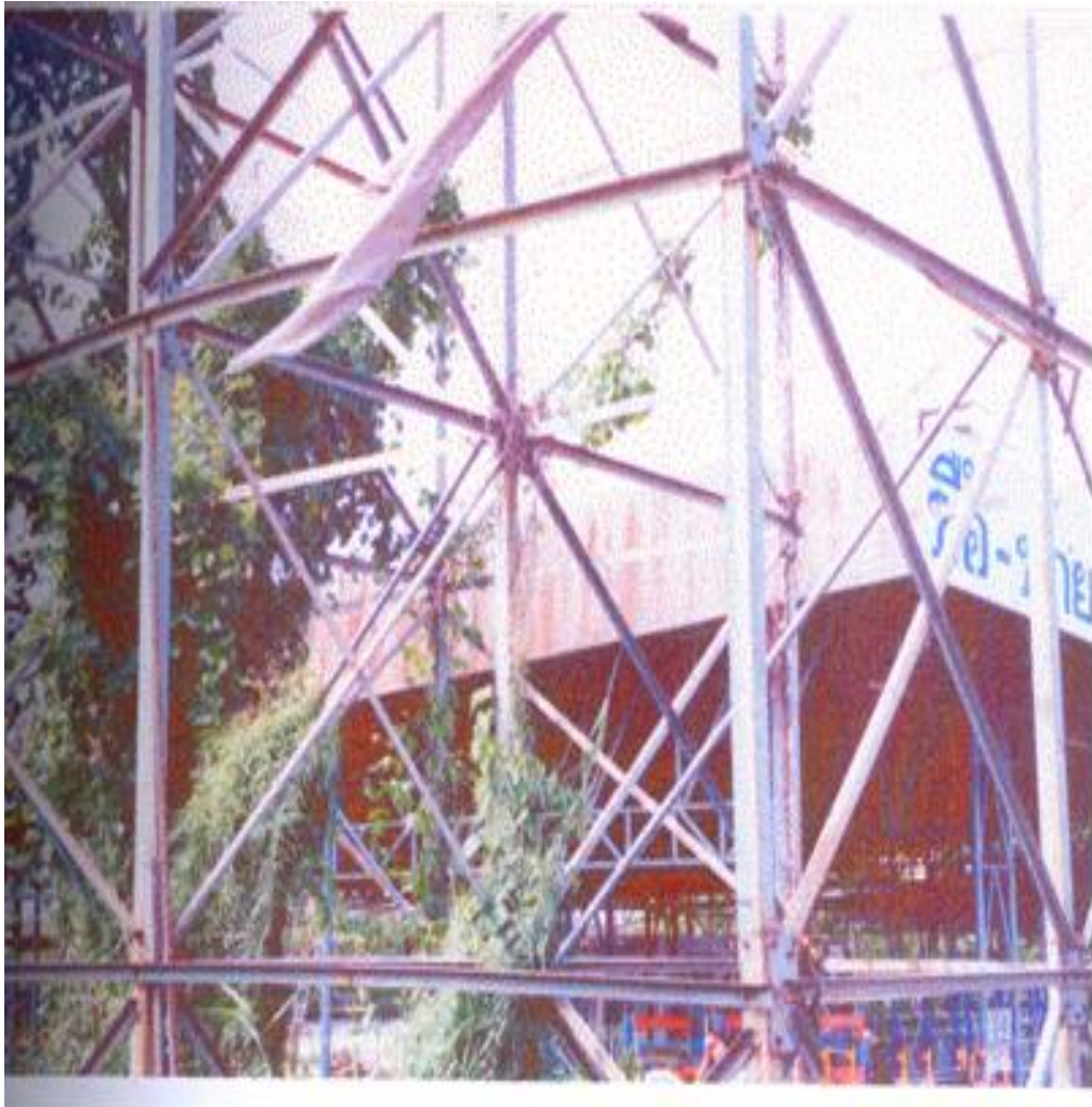
รูปที่ 5. โครงสร้างบิดงอเสียหายเนื่องจากฐานรากทรุดตัว
