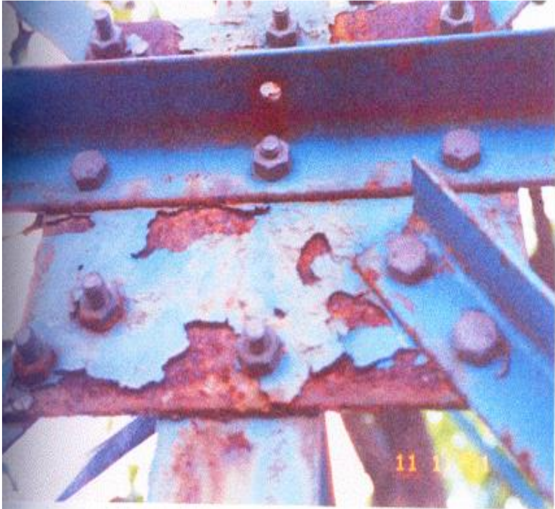
รูปที่ 6. การกัดกร่อนที่จุดต่อเนื่องจากสึหุลดลอก
