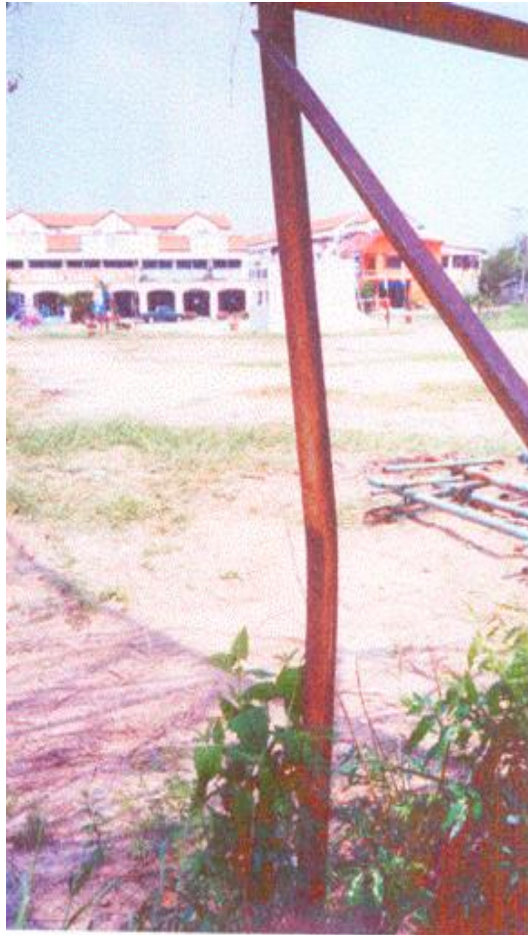
รูปที่ 7. โครงสร้างเสียหายจากการถูกรถชน
