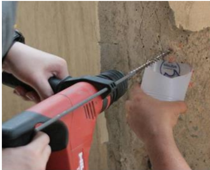
รูปที่ 6: วิธีการเจาะและเก็บผงตัวอย่างจากอาคารคอนกรีตเสริมเหล็ก
