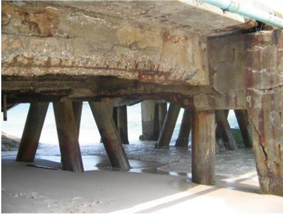
รูปที่ 1: การเกิดสนิมของทำเทียบเรือที่อยู่ริมชายหาด
