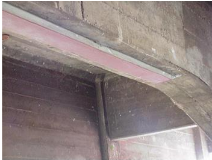
รูปที่ 3 ตัวอย่างการติดตั้งแผ่นเหล็กใต้ท้องคานสะพาน
