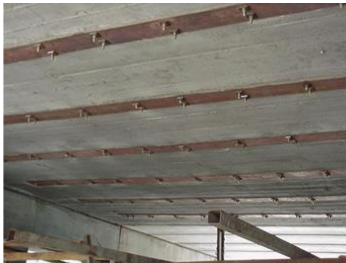
รูปที่ 4 ตัวอย่างการติดตั้งแผ่นเหล็กใต้พื้นสะพาน โดยใช้ฮ็ูป็อกซีร่วมกับสลักเกลียว
