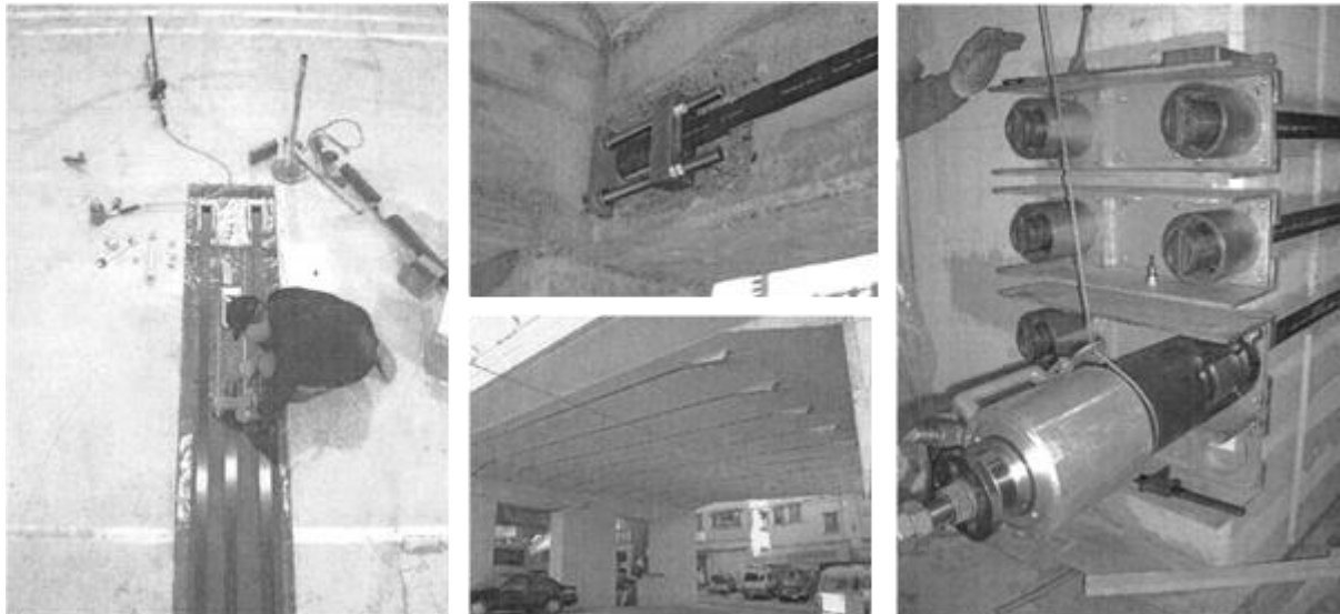
(ก)ตัวยึดแบบ Ds (ข)ตัวยึดแบบ Df ชนิด Non-Stressing (Fixed)รูปที่ 4 ตัวยึดแบบ D
