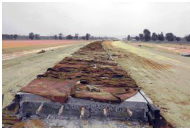
รูปที่ 2 – การบ่มคอนกรีตโดยกระสอบป่าน
