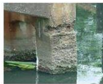
1 ค) เสื่อกรวดไม่เหมาะสมกับสิ่งแวดล้อมที่ก่อสร้างอยู่ที่คอนกรีตเสื่อมสภาพเร็วกว่าที่ควร (สิ่งแวดล้อมมีกรดและซัลเฟต)
