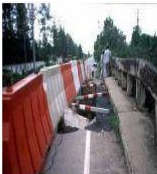
รูปที่ ๘ ตัวอย่างการวิบัติของโครงสร้างคอนกรีตในประเทศไทยที่ขาดการตรวจสอบสภาพและบำรุงรักษา
