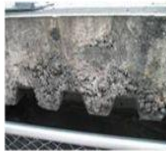
1 จ) ปัญหาการก่อสร้าง (การทำให้คอนกรีตแน่นไม่สมบูรณ์)
