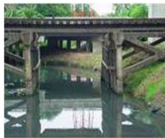
1 ค) เสื่อกรวดไม่เหมาะสมกับสิ่งแวดล้อมที่ก่อสร้างอยู่ที่คอนกรีตเสื่อมสภาพเร็วกว่าที่ควร (สิ่งแวดล้อมมีกรดและซัลเฟต)
