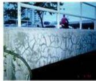
1 ก) เสื่อกรวดโดยไม่ได้ทำสิ่งคุณสมบัติในระยะยาว(ไม่ได้ทำสิ่งปฏิกิริยาAR)
