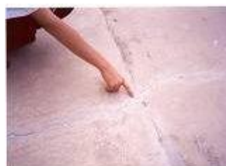
1 ก) ปัญหาที่เกิดจากการออกแบบ(ออกแบบโดยไม่ได้คำนึงถึงการหดตัวทำให้เกิดการแตกร้าวจากการหดตัวที่ถูกยึด รั้ง)
