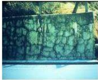
1 ก) เสื่อกรวดโดยไม่ได้ทำสิ่งคุณสมบัติในระยะยาว(ไม่ได้ทำสิ่งปฏิกิริยาAR)
