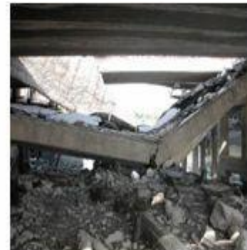
รูปที่ ๘ ตัวอย่างการวิบัติของโครงสร้างคอนกรีตในประเทศไทยที่ขาดการตรวจสอบสภาพและบำรุงรักษา
