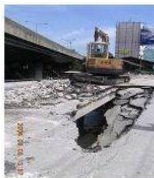
รูปที่ ๘ ตัวอย่างการวิบัติของโครงสร้างคอนกรีตในประเทศไทยที่ขาดการตรวจสอบสภาพและบำรุงรักษา
