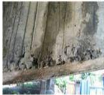
1 จ) ปัญหาการก่อสร้าง (การทำให้คอนกรีตแน่นไม่สมบูรณ์)
