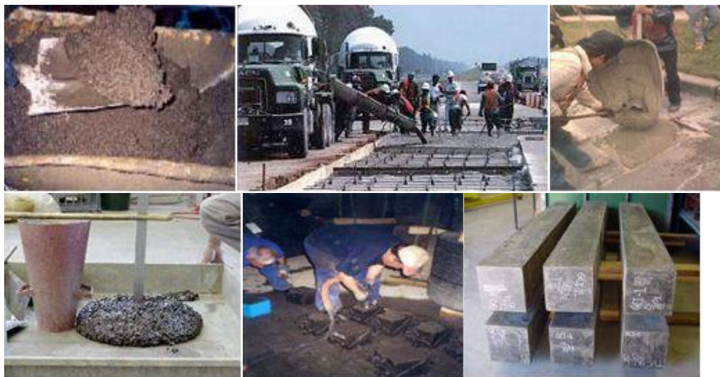
Fig. 8 แสดงการนำไปใช้งานโครงสร้างคอนกรีตและงานซ่อมถนนของวัสดุ Geopolymer
